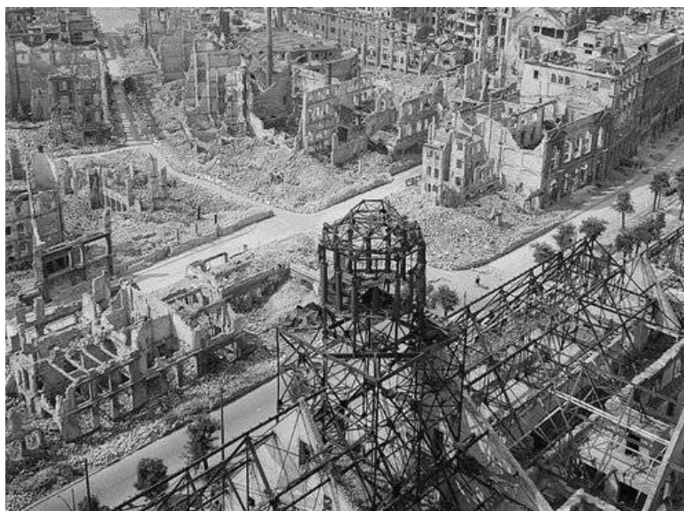
Рис. 1. Фото разрушенный в ходе авианалётов с 13 по 15 февраля 1945 года г. Дрезден [5]
