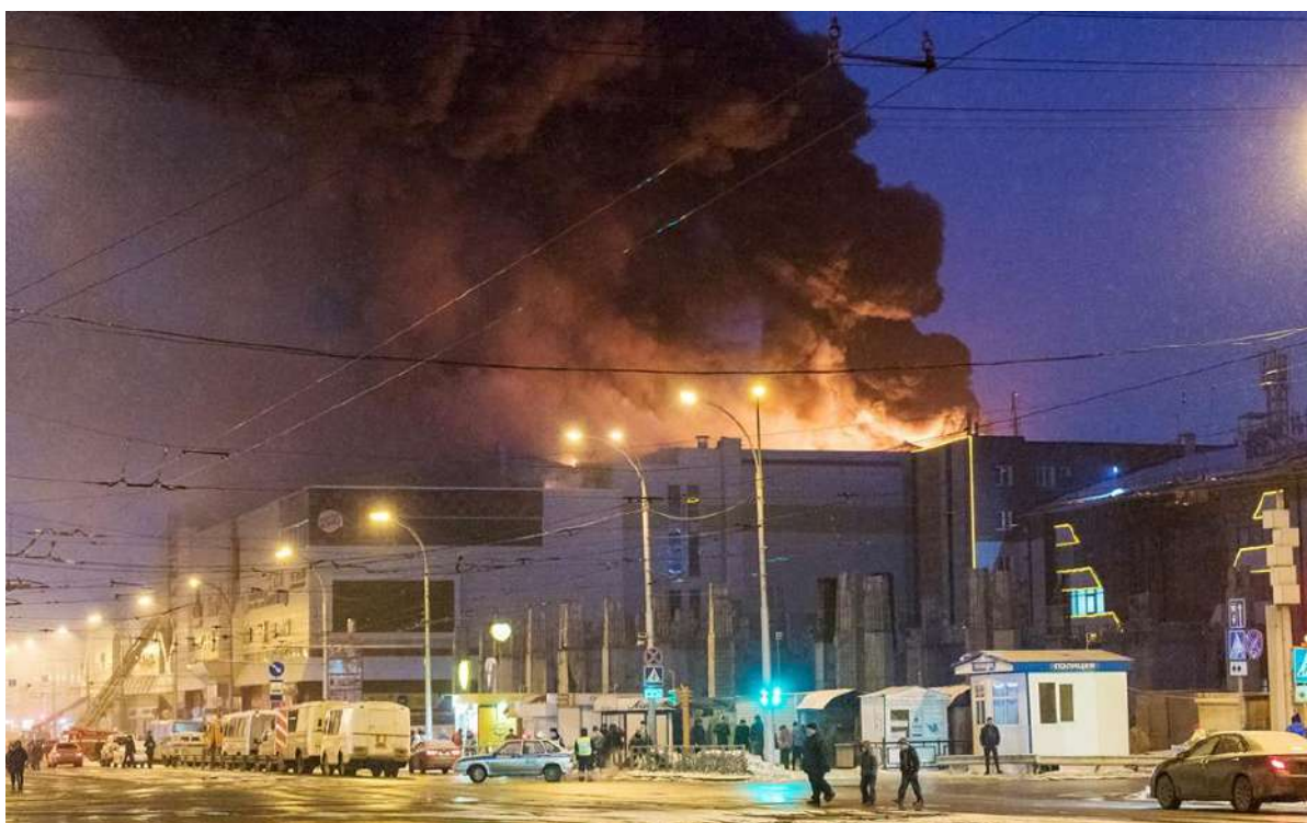
Рис. 3. Пожар в здании ТРЦ «Зимняя Вишня»
